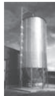
Silo à grains
