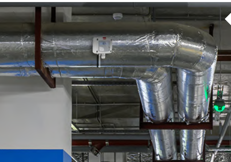
Le CP 112 relié à un dispositif Debimo monté dans un conduit de ventilation. Nos accessoires Debimo spécialisés dans la mesure de débit en page 17.
