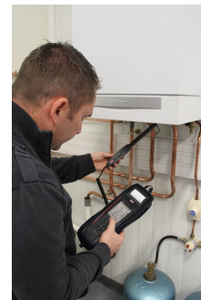
Verificação CO ambiente
